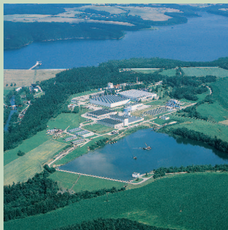
Úpravna vody Želivka
