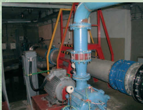
ČS Klíčov – měření průtoku na výtlaku
