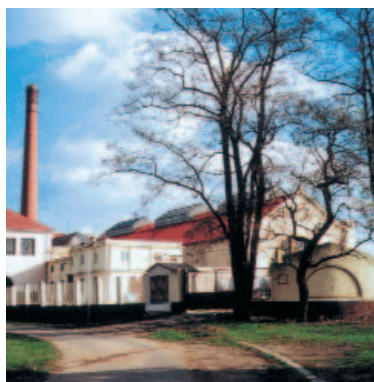
Budova hlavní strojovny v Káraném
