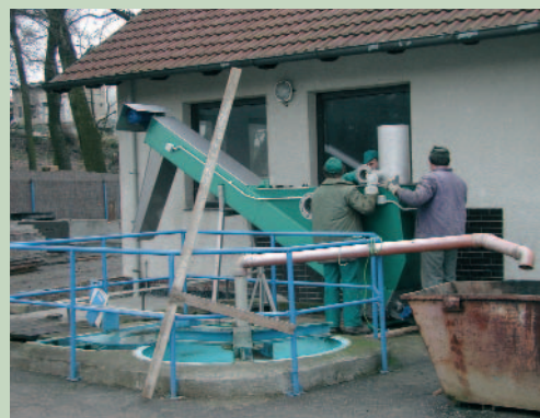
ČOV Kolovraty – separátor písku
