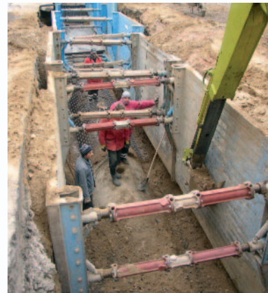
Oprava kanalizace v ul. Sokolovská po povodni
